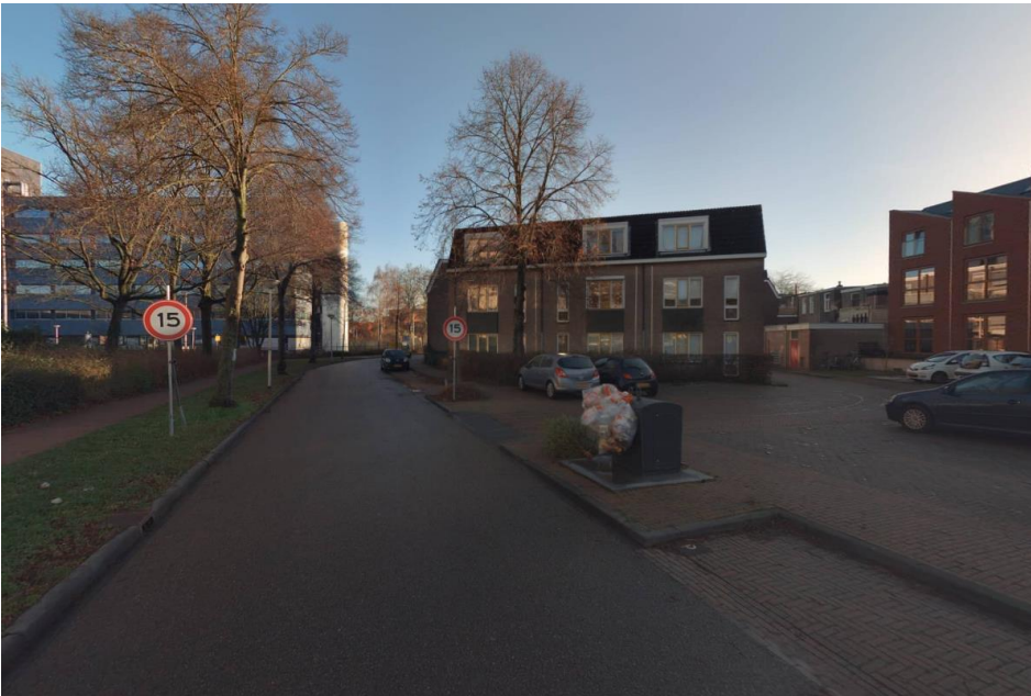
Figuur 17 In- en uitritconstructie, blinde bocht en beperkte zichtlijnen ter hoogte van de kruising Meeuwenlaan – Meeuwenlaan
