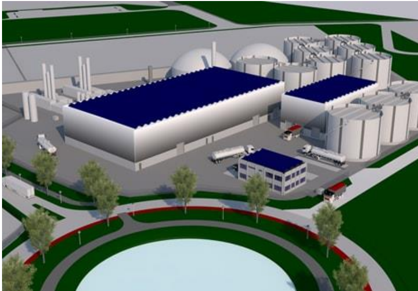
Impressie van de biovergister in Coevorden (input 215.000 ton mest, productie 26 mln.m 3 AE, voor 20.000 woningen)
