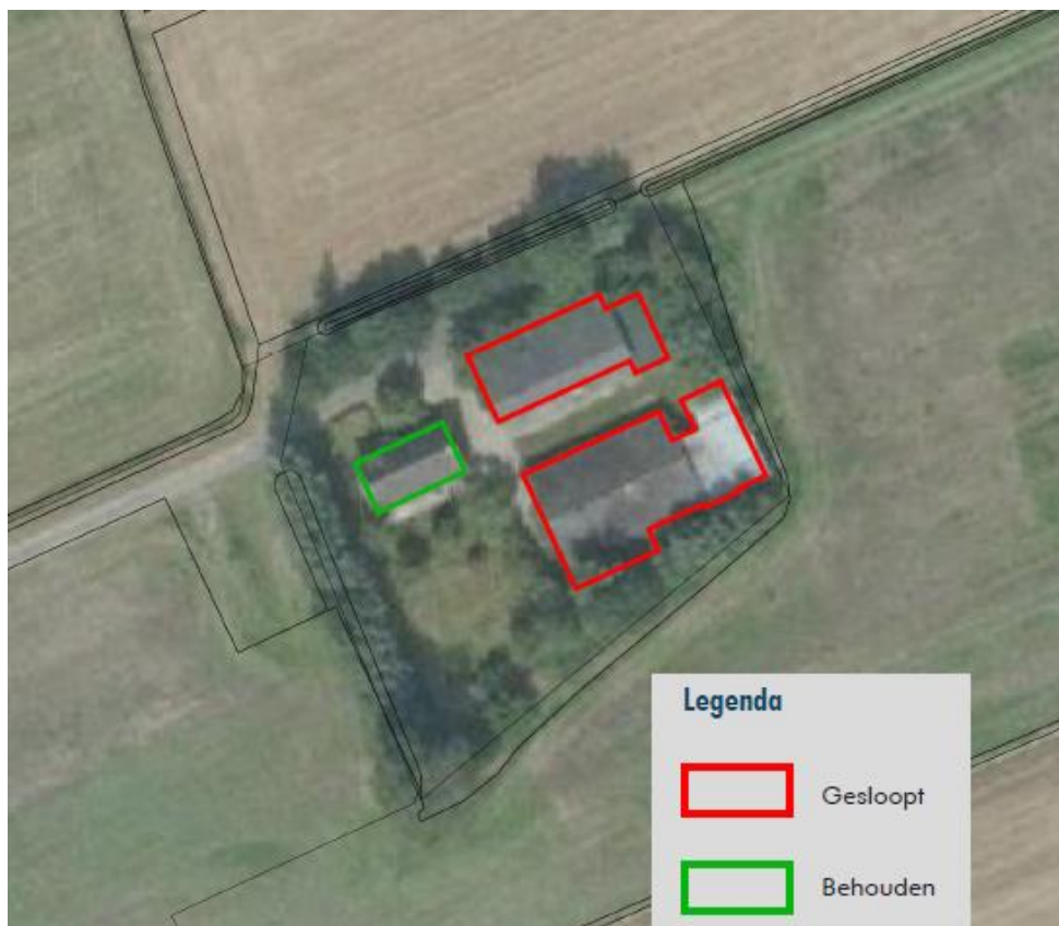
Luchtfoto locatie Wijheseweg 49 voor sloop
