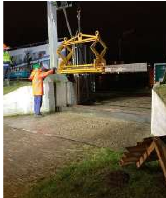
De coupures, een onderbreking in de dijk, wordt gesloten
