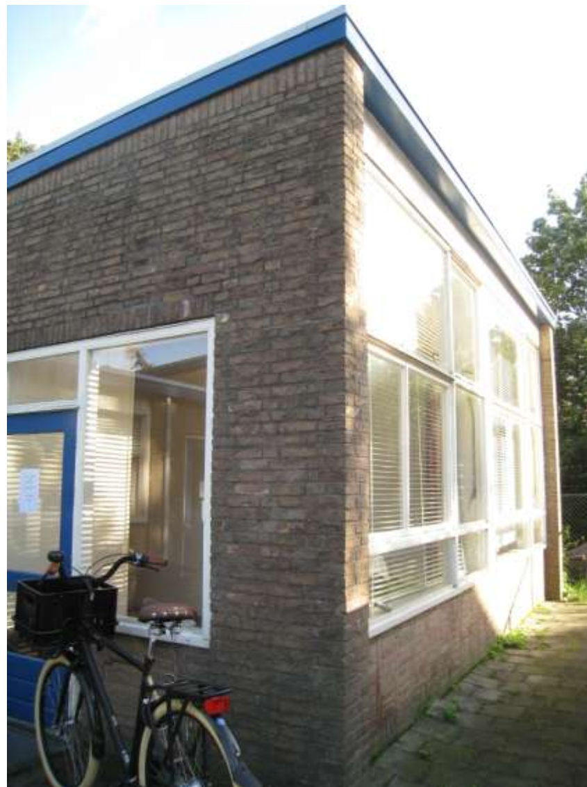
Afb. 29 Lokaal aan de uiterste oostzijde
