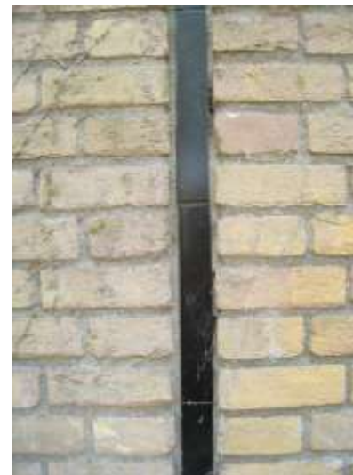
Afb. 41 Detailopname van het metselwerk (gymzaal)
