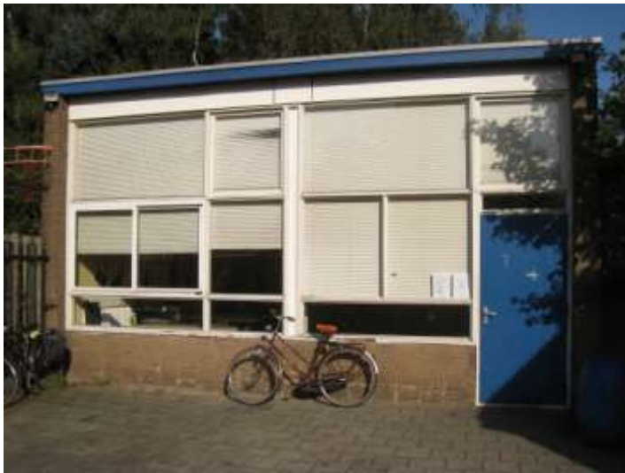
Afb. 30 Lokaalvenster met later ingevoegde ingang
