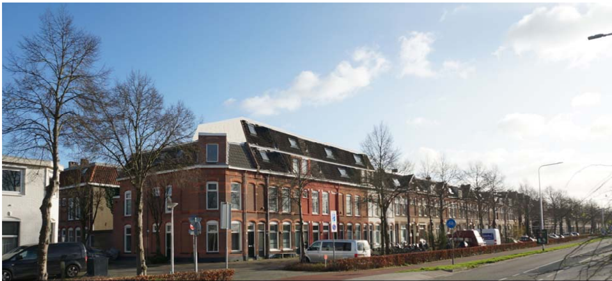
Montagefoto. 4 appartementen op historische woningen Deventerstraatweg
